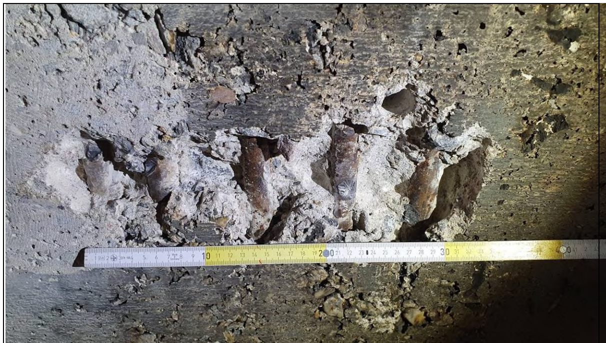
Obr. č. 12 - detail sekané sondy do nosné konstrukce v dilatačním celku č. 3
