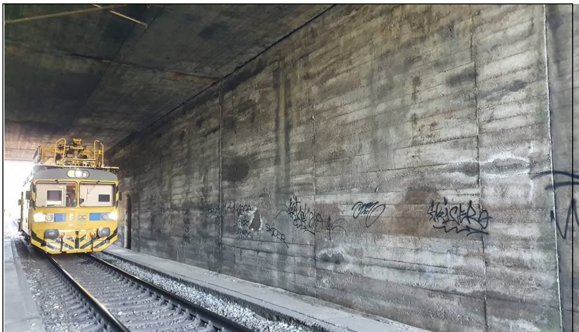
Obr. č. 5 - pohled na opěru Zábřeh na Moravě, lokálně skrze pracovní spáry dochází ke slabým průsakům vody, což má za následek tvorbu map v lici opěry.
