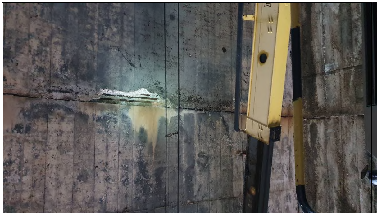
Obr. č. 8 - detail na opady betonu nosné konstrukce dilatační celek č. 4
