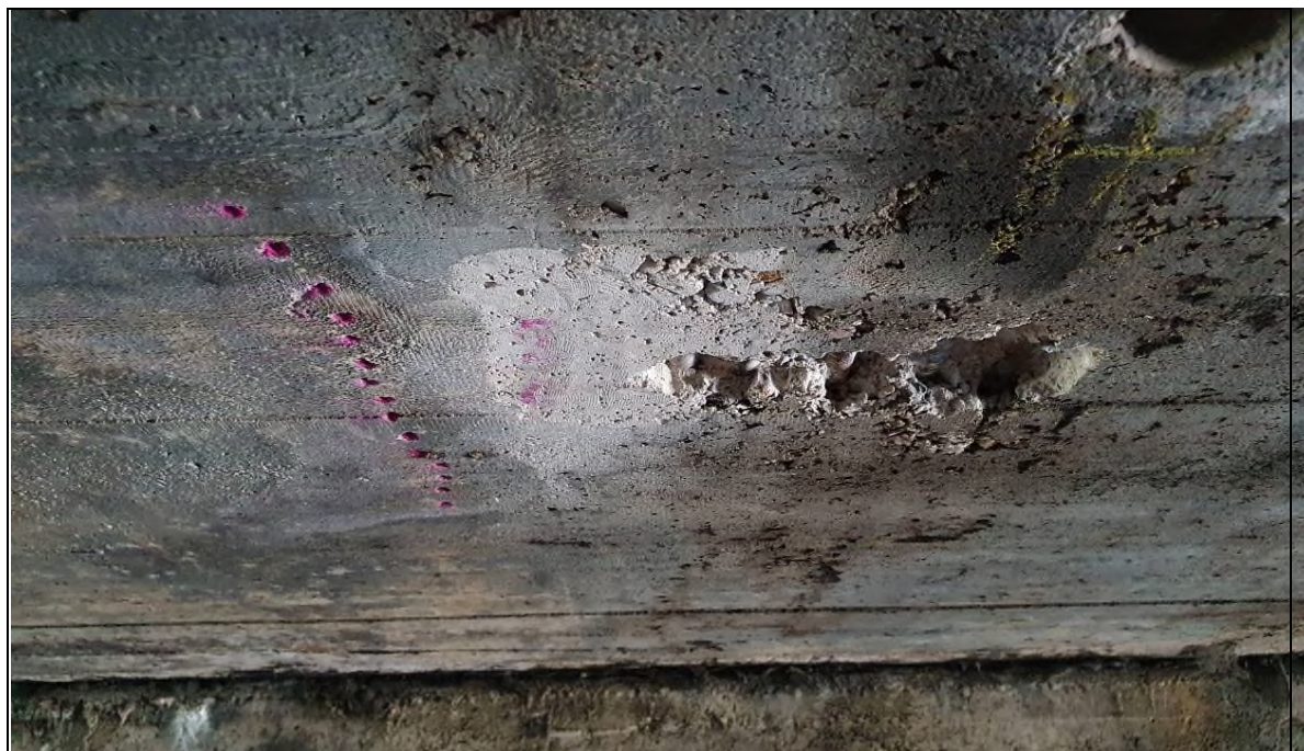
Obr. č. 13 - sekaná sonda do konstrukce
