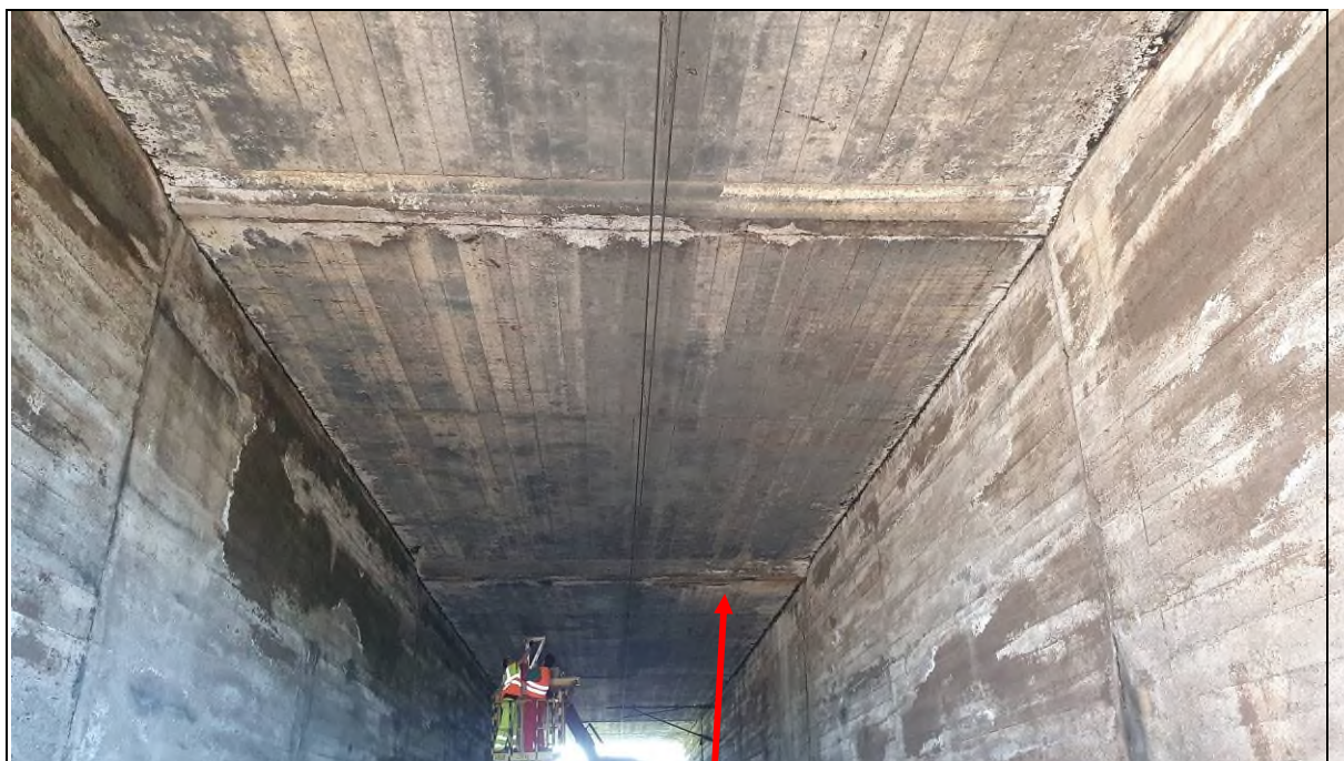
Obr. č. 6 - pohled na nosnou konstrukci, lokálně skrze dilatační spáru dochází ke slabým průsakům
