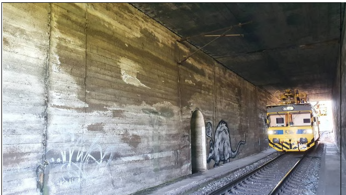
Obr. č. 4 - pohled na opěru Česká Třebová, lokálně skrze pracovní spáry dochází ke slabým průsakům vody, což má za následek tvorbu map v lici opěry
