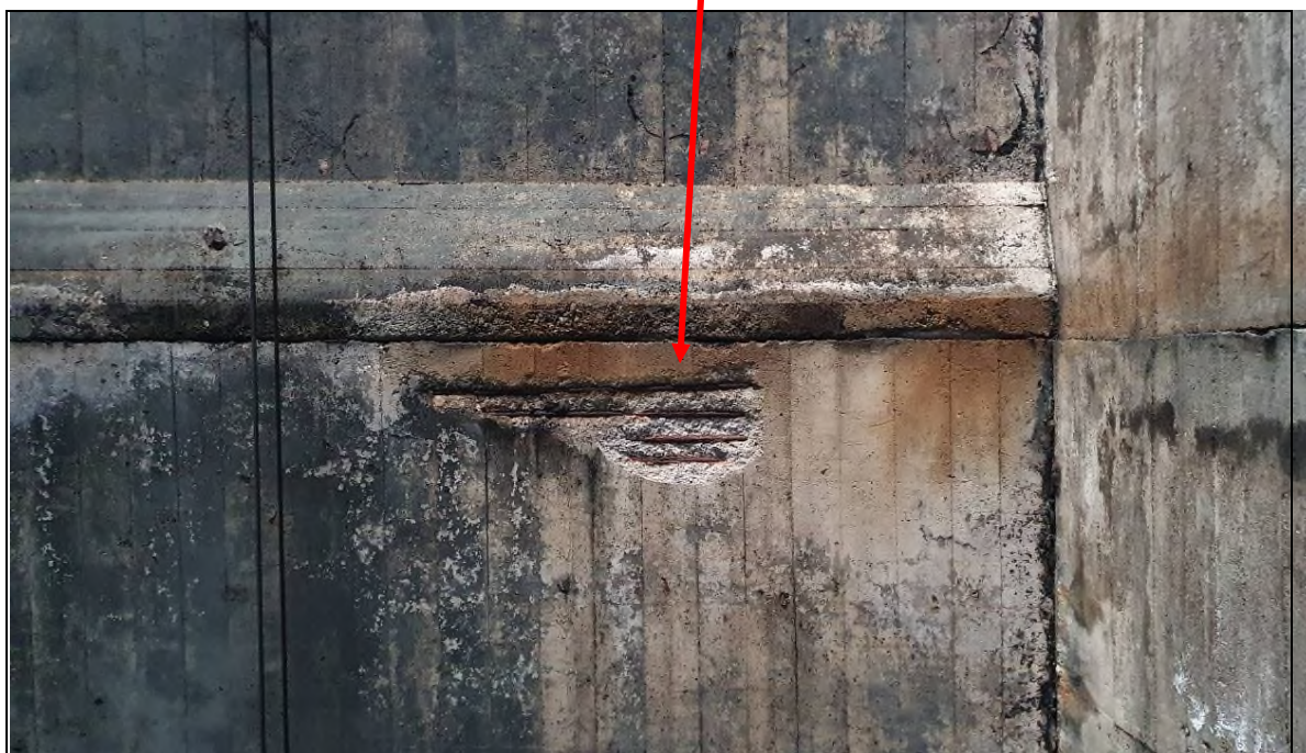
Obr. č. 7 - detail na opady betonu nosné konstrukce dilatační celek č. 3
