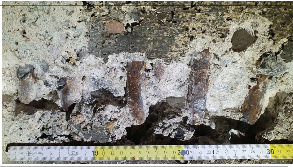
obr. 1 - pohled do sekané sondy do konstrukce
